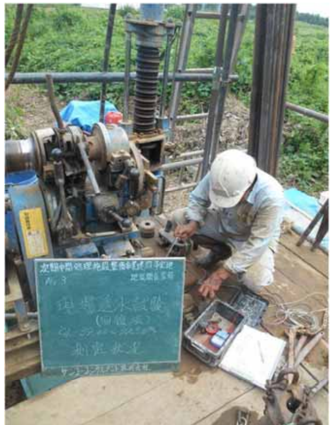
現場透水試験 GL-34.00 ~34.50m
