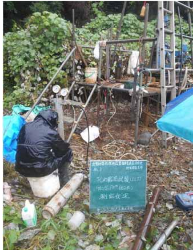
孔内載荷試験(LLT)測定状況 GL- 15.50m
