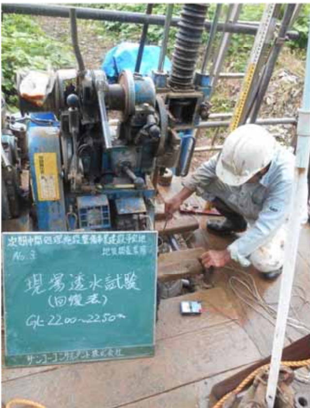
現場透水試験 GL-22.00 ~22.50m
