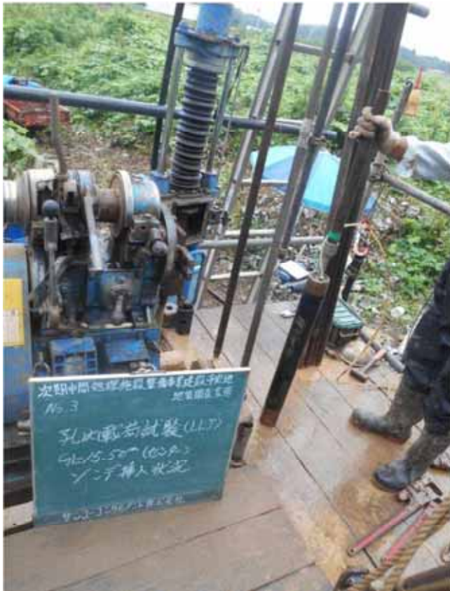
孔内載荷試験(LLT)ゾンデ挿入状況
