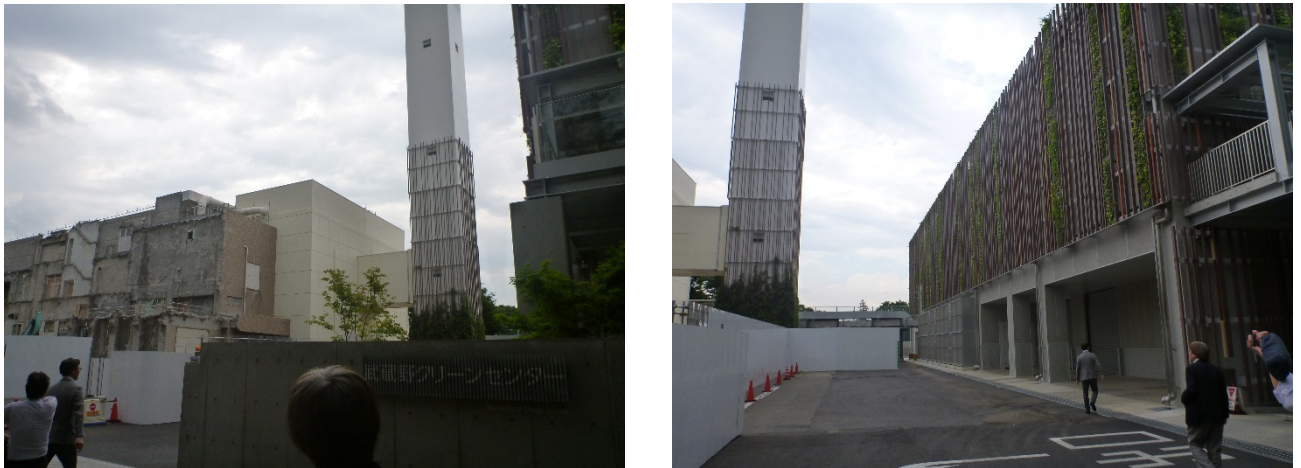
図 1-6-3 武蔵野クリーンセンターにおける既存煙突の再利用状況
