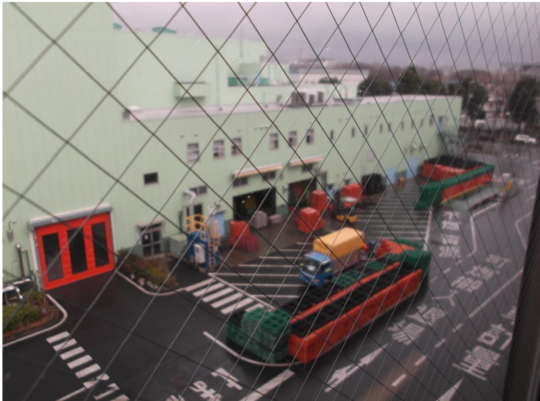
⑥ 3階からリサイクルセンター（粗大・不燃ごみ処理施設、資源物の選別施設）を望む。
