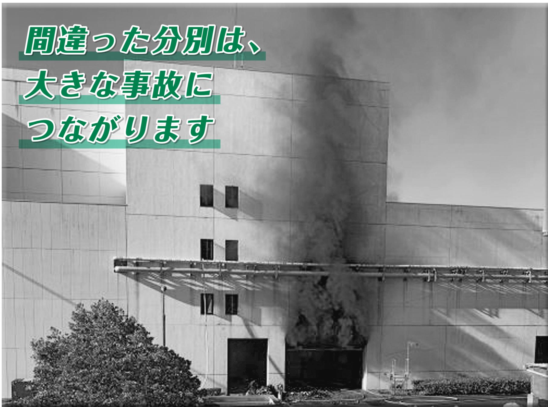
令和6年12月27日午前7時57分ごろ、印西クリーンセンターの粗大・不燃ごみ処理箇所で火災が発生しました。消防署において火災の原因を調査中ではありますが、廃棄物に混入されたリチウムイオン電池が原因である可能性が高いと考えられています。
