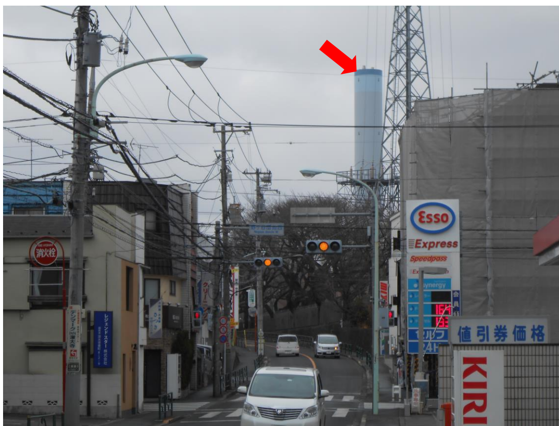
③南西へ 590m (野ヶ谷団地西交差点付近)
