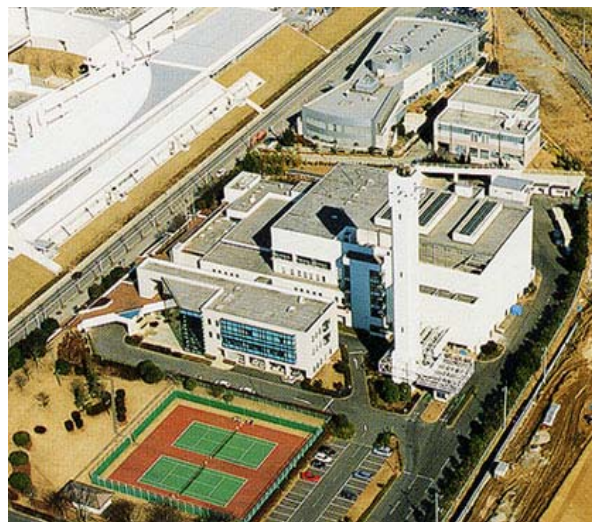
図 41 印西クリーンセンター
